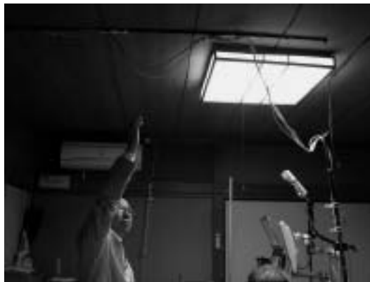
写真7 天井に這わせ配線 (人物は第二著者の水月である。天井の高さのスケール感を示すために右手を挙げている。撮影：日高)
