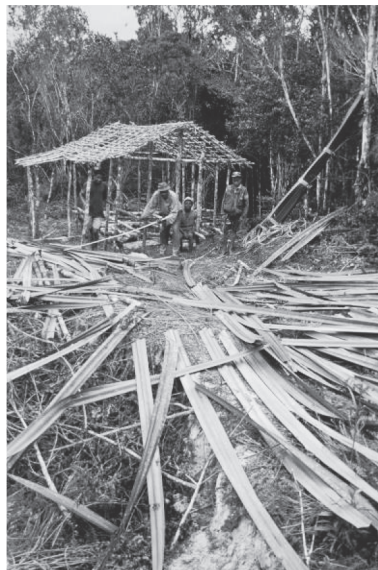
図3 バンダナスの葉で屋根を葺く （ムラマンガ近郊で）
