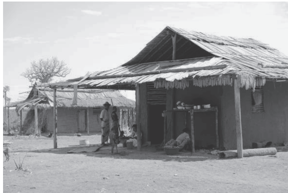
図4 バオバブの樹皮で屋根を葺いた家屋（ムルンダヴァ近郊で）
