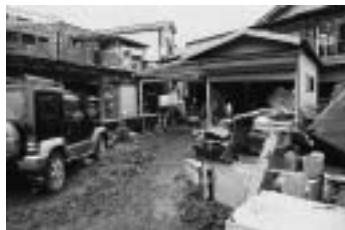
写真3 佐用町商店街栄町付近。大量の土砂が濁流と共に流れ込み、多くの車両や家財道具が廃棄された。浸水した家屋の復旧には早いところでも数週間を要した。2009年8月12日撮影。
