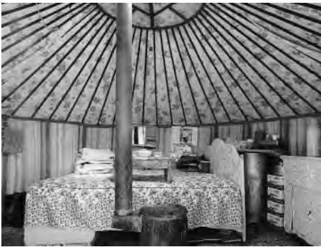
このゲルの骨組みは鉄製で、天窓、天井、側壁はいずれも溶接されている。
