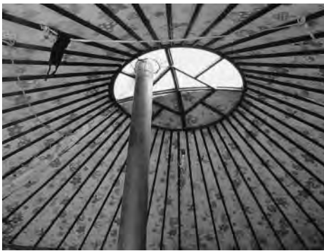
煙突を天窓に接触させないよう既製の器具が設置されている。
