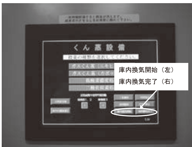
図14 燻蒸設備計装盤の画面排気ダクトの位置 (企画課作成)
