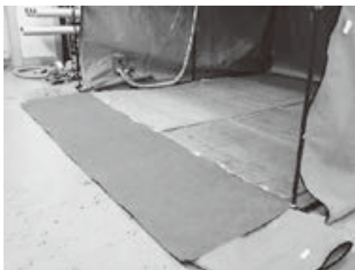
写真7 移動棚搬入のための養生マット（2004年4月9日 筆者撮影）
