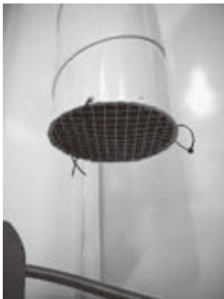
写真10 排気ダクトの網のふた (2021年10月7日 筆者撮影)
