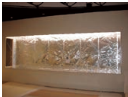
写真7 アルミニウム箔で合板を養生した展示ケース (2008年8月21日 筆者撮影)
