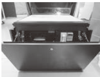
写真13 展示台下の調湿剤ボックスへのVOC等ガス吸着シートと送風機の設置 (2019年7月9日 筆者撮影)
