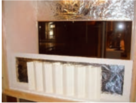
写真9 展示台の背面への調湿・マルチガス吸着シートの設置 (2009年3月10日 筆者撮影)
