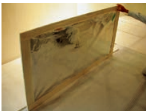
写真6 アルミニウム箔で養生した合板にタッカー留めでクロス貼りをおこなう。(2008年8月21日 筆者撮影)
