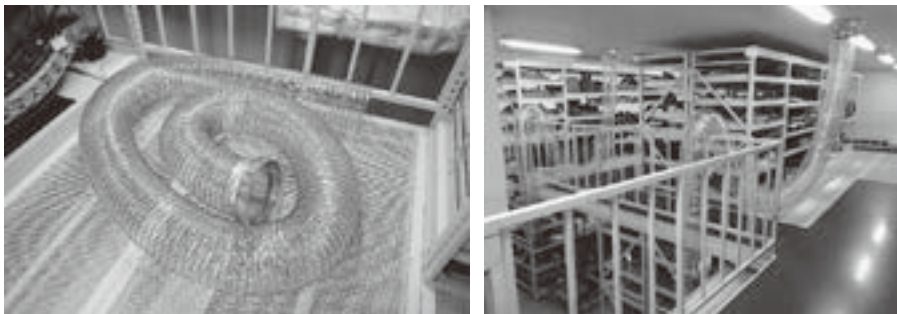
写真1 新たに採用した簡易ダクト 左：取り外した状態(2021年10月14日 筆者撮影)、 右：取り付けられた状態(2021年11月11日 撮影：橋本沙知)
