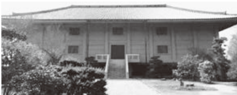
写真 4 西宝庫（撮影：宮内庁正倉院事務所）
