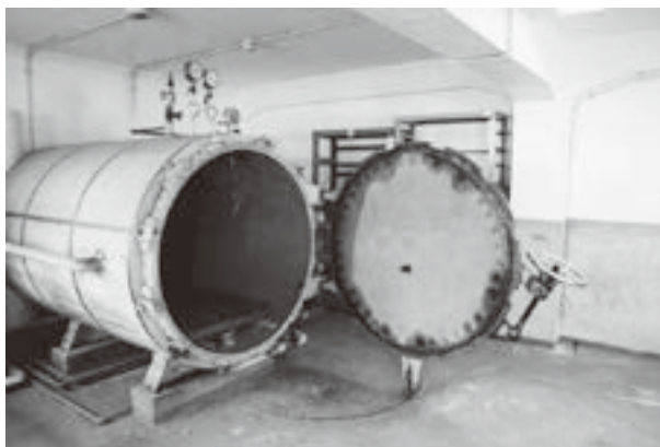
写真8 文化財用燻蒸装置（撮影：宮内庁正倉院事務所）
