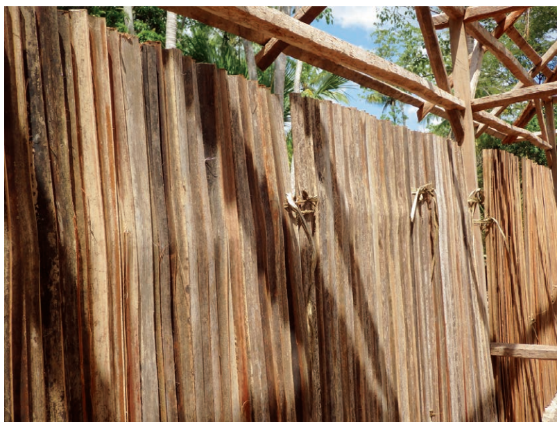
写真 20-A タラバヤシの利用例 建物の壁材 ( klpit )
