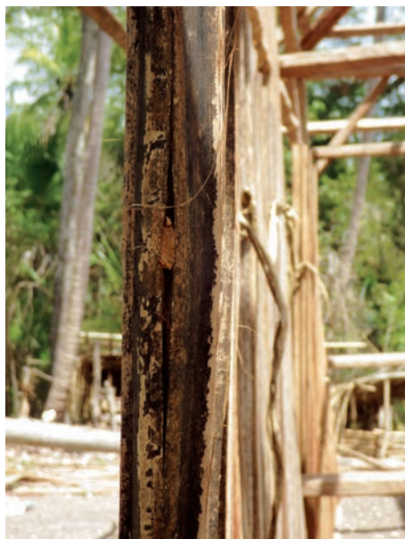
写真 16-A ビンロウの利用例 壁材をつなぎとめるヨコ串 (anef)
