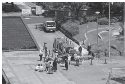
写真 21 翼部分の取り付け作業。国立民族学博物館，2020年6月23日，西下真弓撮影。
