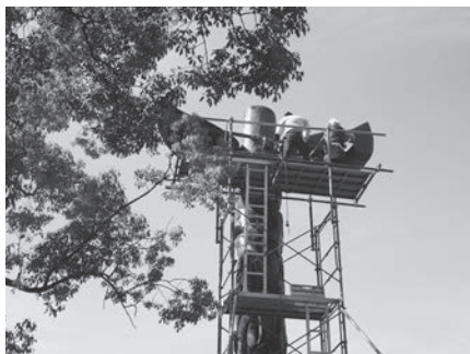
写真 23 トーテムポールの翼の仮固定作業。国立民族学博物館，2020年6月24日，中村真里絵撮影。
