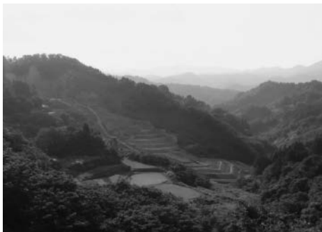
写真1 工事中の清水の棚田 (2012年筆者撮影)
