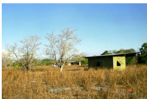
84年完成の1部屋簡易住宅, 1998, 久保
