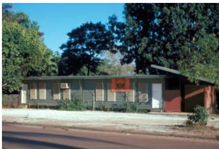
JET センター事務棟, 2004, 堀江
