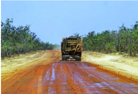
盛土固化のための散水，バリジョーウェン付近，1998，久保
