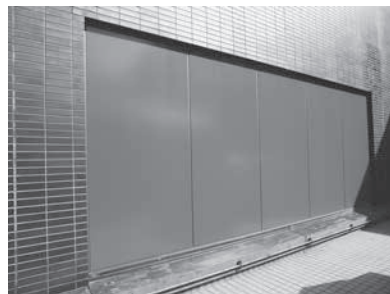
写真19 破損した大型ガラスをアルミパネルに変更した箇所 2019年3月9日 筆者撮影
