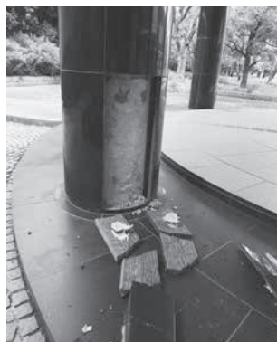
写真4 前庭大理石の破損 2018年6月19日 国立民族学博物館財務 課施設係撮影
