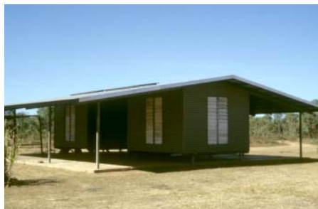
パネル製簡易2部屋若者用宿舎、ジベナ、1998、堀江
