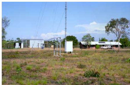
4部屋ブロック本格住宅とインフラ（屋根ソーラーパネル＋シャワー洗濯棟＋電話＋作業場）、ジベナ、1998、久保
