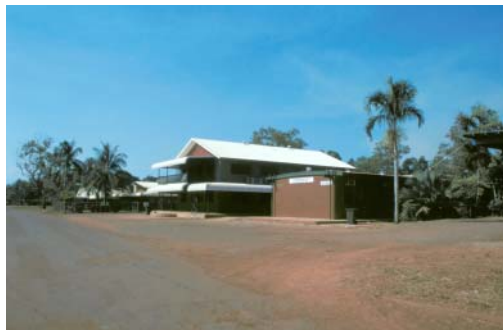
新 MPA 中心施設 (奥 : 売店, 中央 : 事務棟, 手前 : テイクアウト), 2004, 堀江
