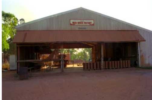
CDEP マッドブロック製造工場, MGD, 1998, 久保
