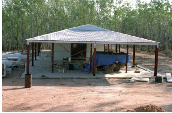
左ページのワニ Jocky を観測したメッセル展望台の跡地に建つ、レンジャー・ステーション研究棟, 1997, 堀江
