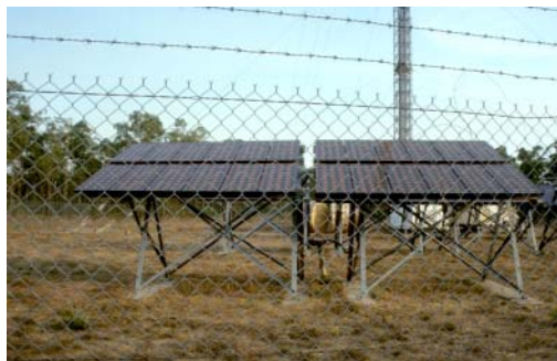
ダムダムの中継塔（右）と中継機ソーラー電源, 2004, 堀江
