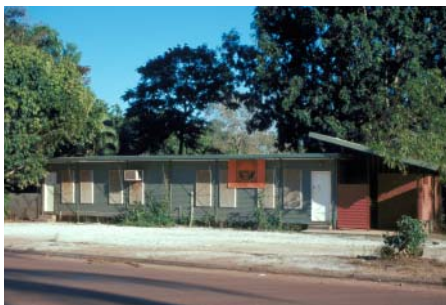
JET センター事務棟, 2004, 堀江
