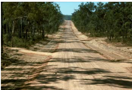
側溝と排水溝，マニングリダ南部，2004，堀江
