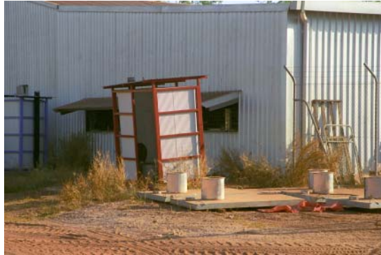
トイレ棟とトイレの製造, MGD・ BAC 作業工場, 1998, 久保
