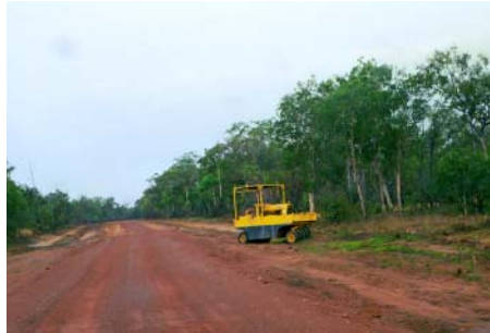
路盤工専用タイヤローラー，バリジョーウェン付近，1998，久保
