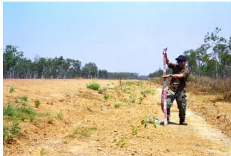
完成道路。盛土厚約1.2m，バリジョーウェン東，1999，久保
