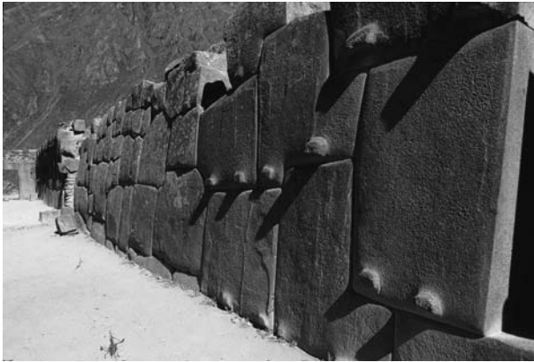
写真5-4 オヤンタイタンボの城塞の石壁。巨大な石をきっちり積み上げている
