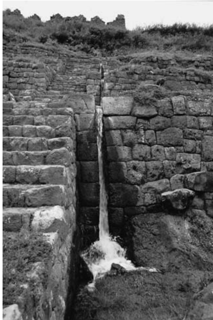
写真 5-8 ティボン遺跡の灌漑水路。ティボンはクスコ近郊にあるインカ時代の遺跡。階段耕地に立派な水路がひかれている
