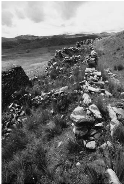
写真 5-17 ワヌコ・パンパの倉庫群。山の斜面に直角に約500の倉庫群が整然とならんで建っている
