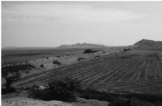
写真4-5 アスコベの水路。ペルー北部の海岸地帯にあり、日干しレンガを積み上げた堤道の上に灌漑水路が走っている
