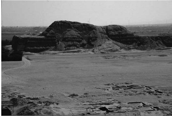
写真4-4 モチエの「太陽神殿（ワカ・デル・ソル）」。日干しレンガを積み上げて造られている
