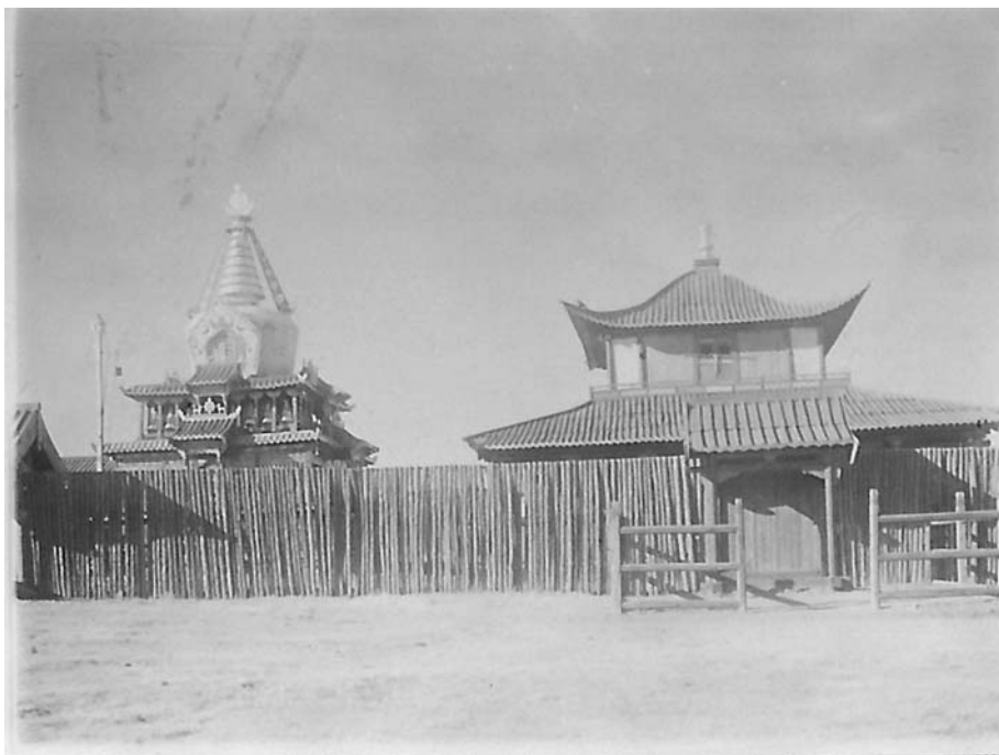
26. Дуйнхор дацан в Чжалхэнцзи. Вид с S.
