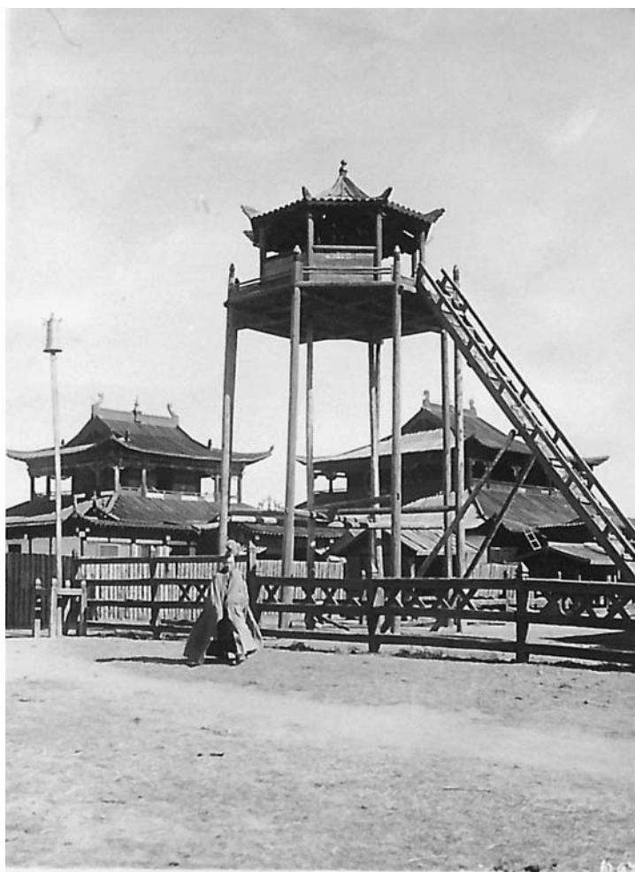
52. Вышка в Дурекчиване.
