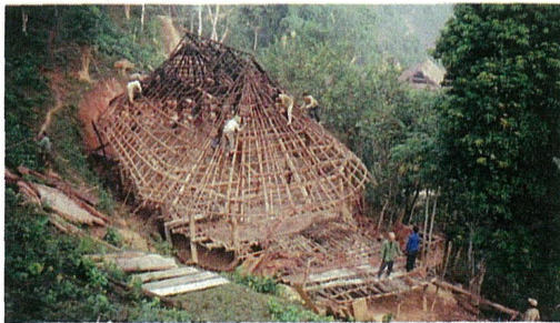
写真4 「亀の甲」型の家の解体
