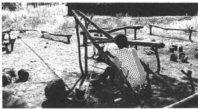
写真4 複合単式番目綜統型の開口具をともなった錘り機による機織り (カメルーン、テテ村：2000年)
