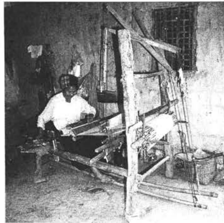
写真5 複式番目綜統型の開口具をともなった枠機（高機）による機織り (中国、雲南省瀾西県芒黒村：1996年)
