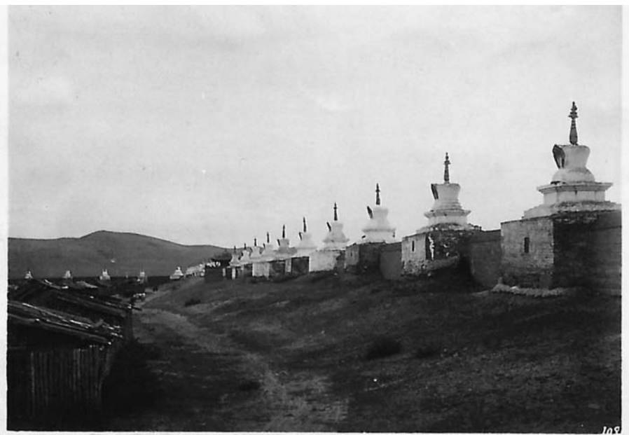
64. Западная часть стены в Эрдэни-Цзу
