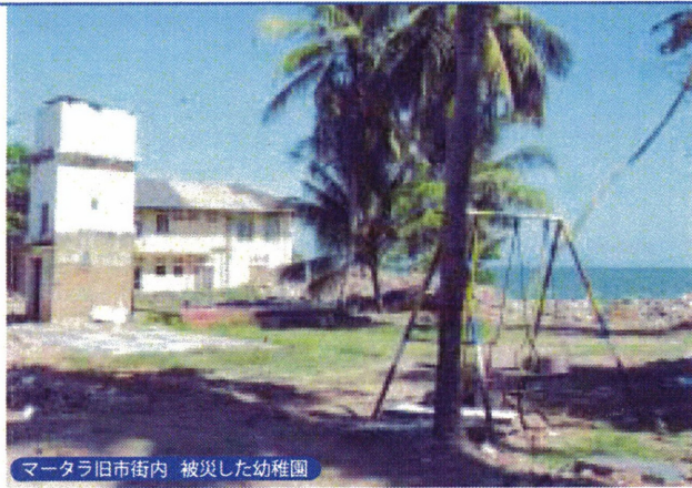
マータラ旧市内 被災した幼稚園
