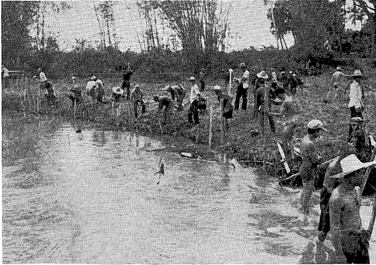
写真30 護岸のための大杭打ち (1975年 5 月14日)
