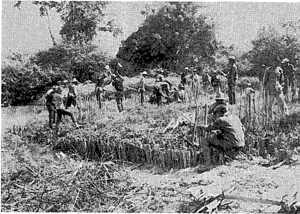
写真28 堤体の外側への拡張 (1975年5月14日) 新しく杭の打ち込まれた部分。
