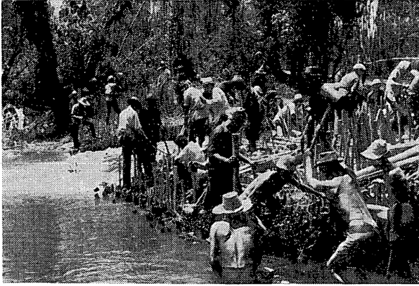
写真27 越流吐付近の堤体における杭打ち (1975年5月14日)
