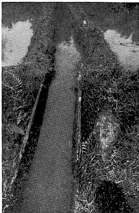
写真21 チーク半裁材の樋口 pāk tāng nam (1975年7月) 樋口幅 約 50 cm
