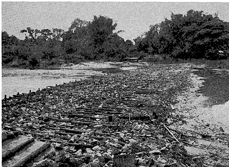
写真6 渇水期における、ピン川本流に架設された Phayā Kham 堰 (1975年2月) チェンマイ盆地の沖積平野型灌漑体系を形成する典型的な堰。
