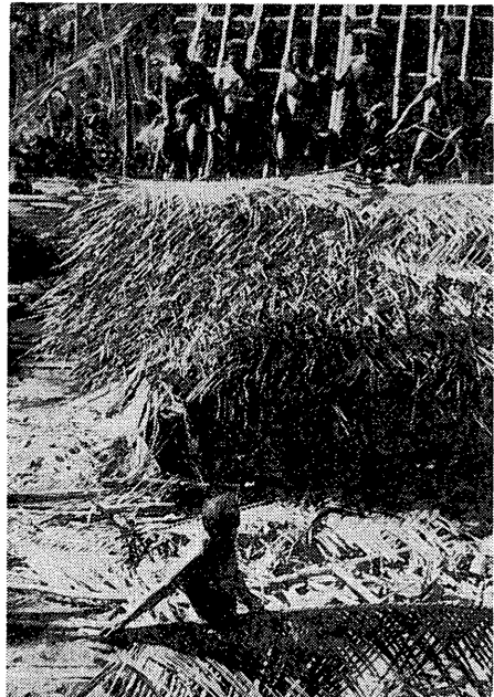
写真5 カヌー小屋の屋根の葺き替え作業、手前の男が持っているのがココヤシの葉を編んだマット ( iashi )。
