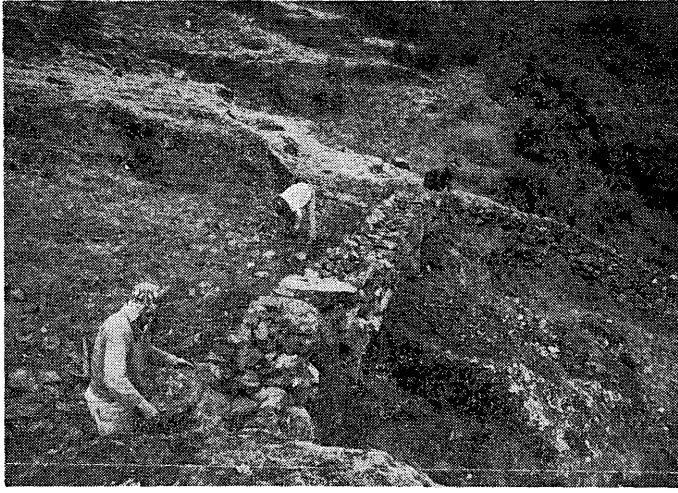
写真18 耕地の周囲に石垣を積みあげる作業、ピルカスカ。これはキタ・チャクラでの作業である
