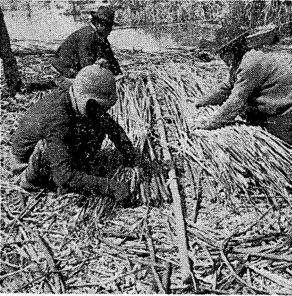
写真21 尺棒がわりのサオの両側にトトラを敷く
