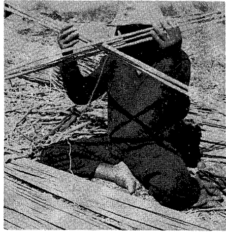
写真39 ウロ族の家の屋根づくりトトラの茎の中央部に糸をとおす
