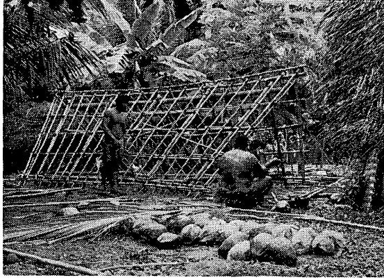
8. 第3棟木をしばりつけ、屋根の部分が完成する。
