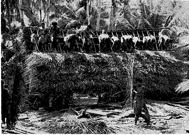
写真11 屋根ふき。屋根材は、一列づつ順にふかれる。
