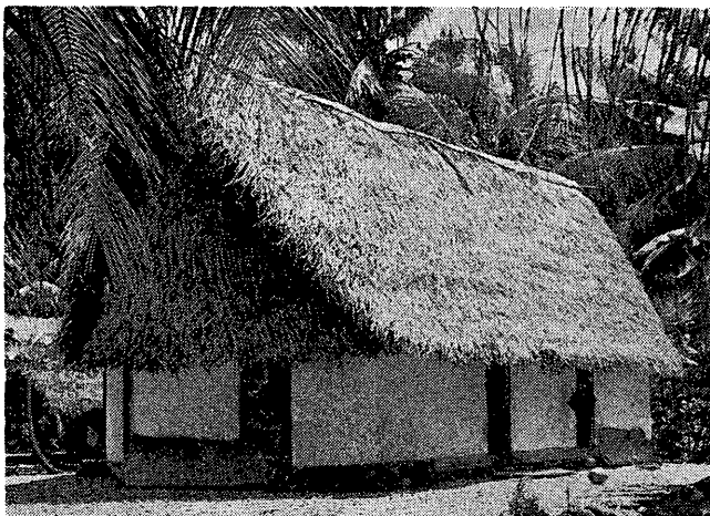
写真6 imwtipaap 合板で壁面がつくられている。平面型は、ヤップの家屋にて長六角形となっている。
