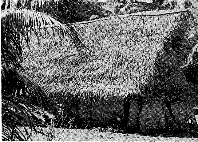
写真5 imwtipaap パンノキで板壁をつくる伝統的な様式で建てられたものである。
