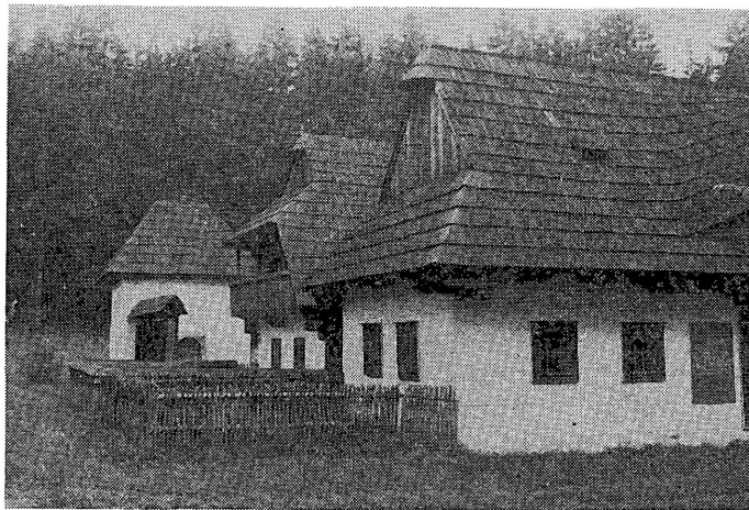
写真6 スロヴァキア、Orava 地方の民家（柿葺、特異な屋根、妻側上端の円錐半割状の小庇がこの地方の特色） [マルチン野外博物館]
