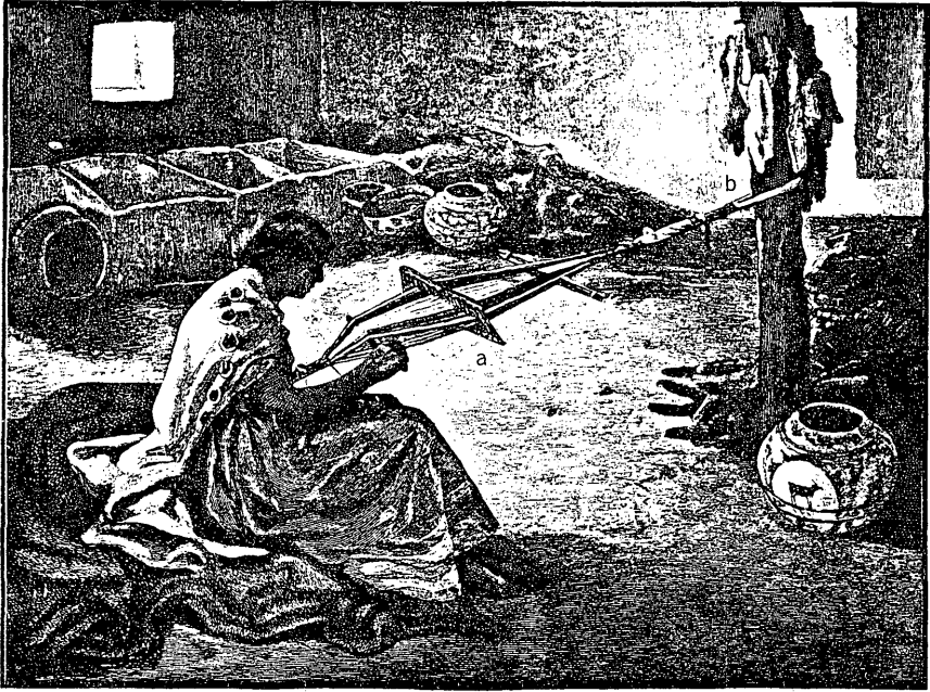
図114 Elfcd 型機 = Zuni 族の “Rigid-Heddle Loom” [MATTHEWS 1884: Pl. XXXVII] (図中の記号 a, b は吉本による)
