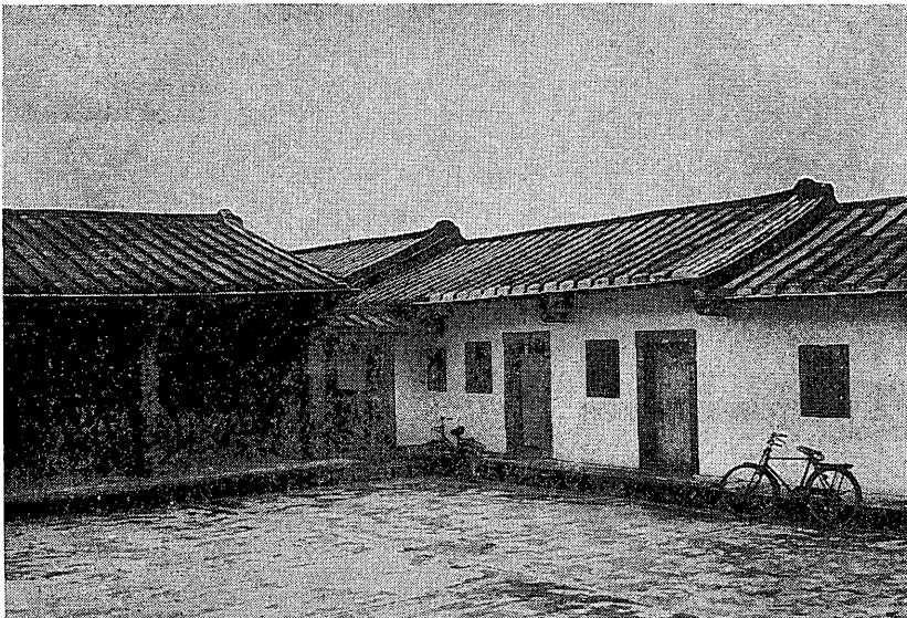
写真1 台湾民家の屋根
