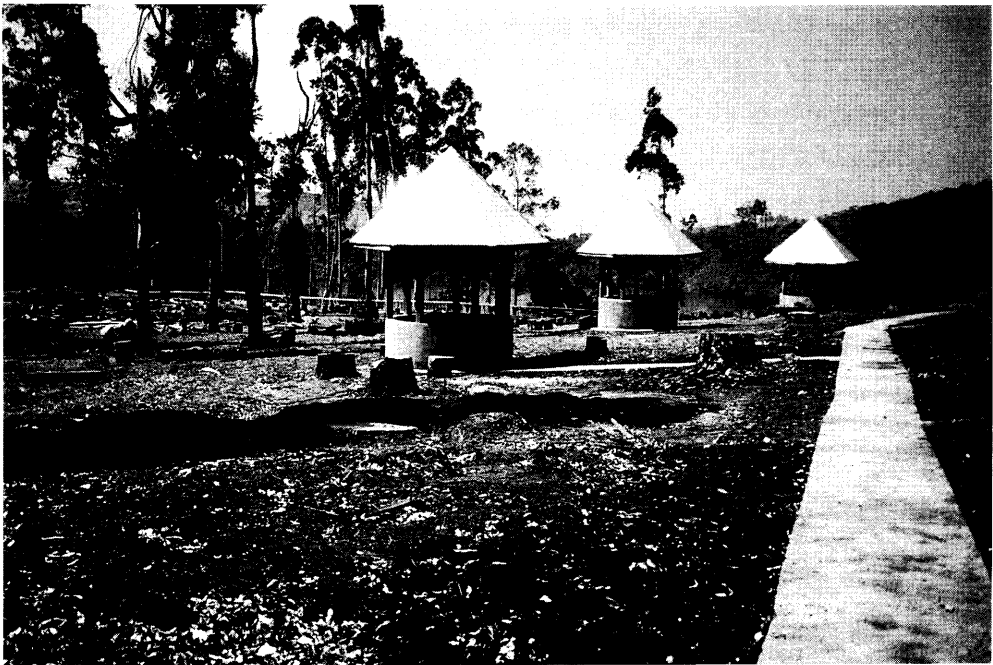
写真1 現在、施工中の「レイク・アウイン・ツーリストティック・プロジェクト」 (筆者撮影)
