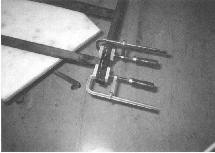
写真5 破損部の接着および補填
