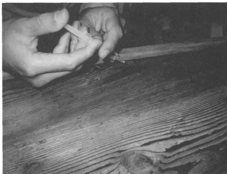
写真4 木の内部で錆びている鉄釘に樹脂を注入
