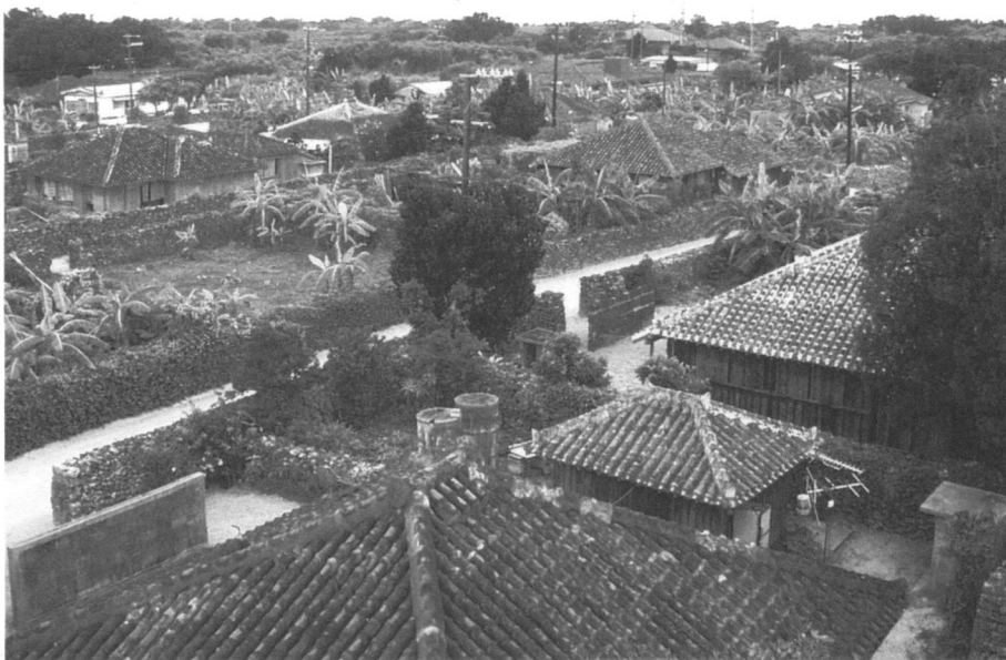
写真1 重要伝統的建造物群保存地区に選定されている集落景観
