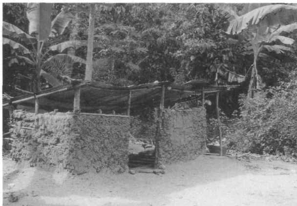
写真8 村の外れにある共同便所
