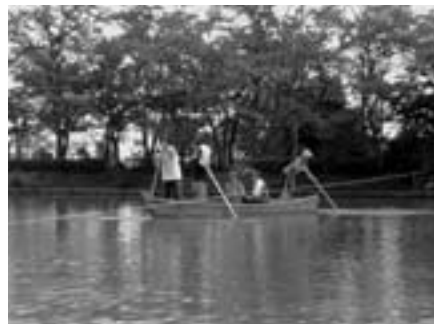
写真 4-2 水深測量調査
