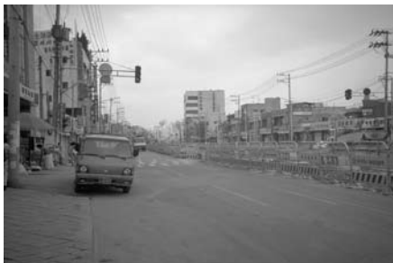
写真8 地下鉄工事 1996年8月
