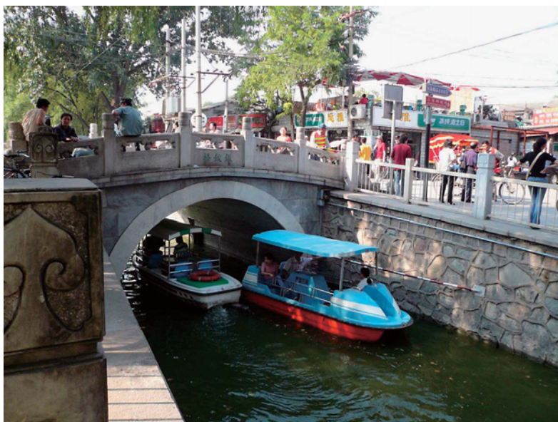
写真5 銀錠橋—前海の尽きる地点—(2006年9月17日撮影) ※橋の欄干に単士元(もと故宮博物院副院長)の揮毫により「銀錠橋」と刻まれている。
