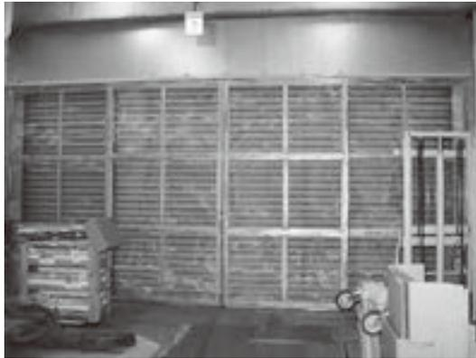
写真1 大型シャッターに取り付けた金属製の網戸
