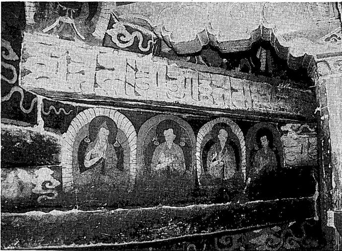
写真52 8階の油煙と炭化による損傷例
