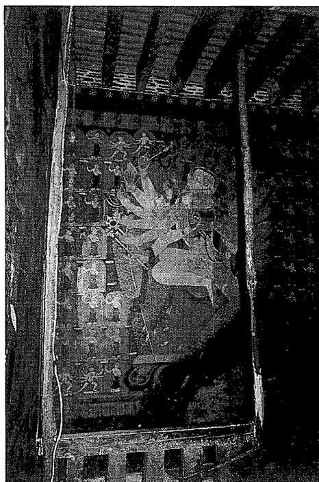
写真50 7階の油煙による損傷例
