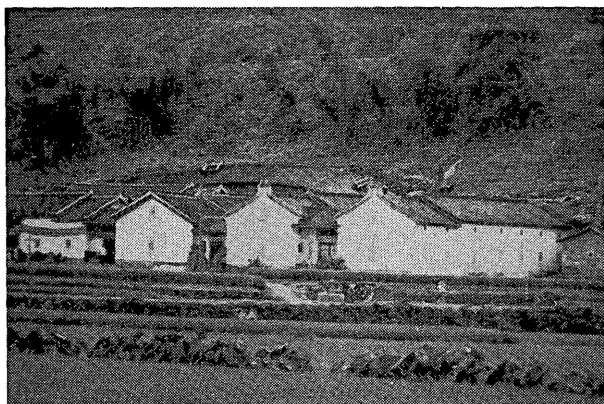
写真17 三堂二横式住居，後部に囲屋が弧状になっているの見える（広東省梅県南口公社）
