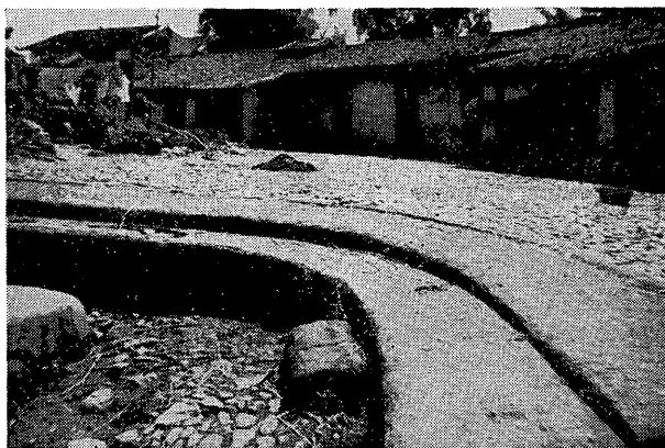
写真23 三堂二横式住居の後部にある厝屋と凉院（広東省梅県梅江公社半坑）
