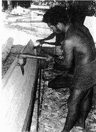
写真3 線を手斧で削り落とし、船底部の形を整える。
